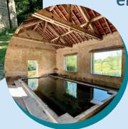
**Thizy** : Le lavoir de Fontenille est un édifice remarquable datant du XVIII<sup>e</sup> s. Construit en moellons de calcaire, il présente une couverture en laves reposant sur une puissante charpente voûtée en berceau plein-cintre. Certains pensent qu'il s'agissait à l'origine d'une salle de garde du château fort voisin. Sur la façade, une sculpture de la déesse gauloise Epona, œuvre de Michel Roetzer. En contrebas du village, un autre lavoir offre une vue magnifique sur le château.
