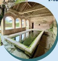
**Marmeaux** : Construit en moellons de calcaire, il présente une architecture simple mais fonctionnelle, avec un toit en tuiles et des ouvertures permettant une bonne ventilation. Le bassin rectangulaire, bordé de margelles en pierre, était alimenté par une source voisine, assurant un approvisionnement constant en eau.
