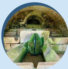
**Blacy** : Le lavoir, situé en contrebas du village, est un exemple remarquable d'architecture rurale du XVIII<sup>e</sup> s. Sa structure en pierre calcaire comprend un bassin rectangulaire alimenté par une source jaillissant de la roche, captée dans un bassin en demi-lune. L'ensemble est abrité par une voûte en pierre sèche.
